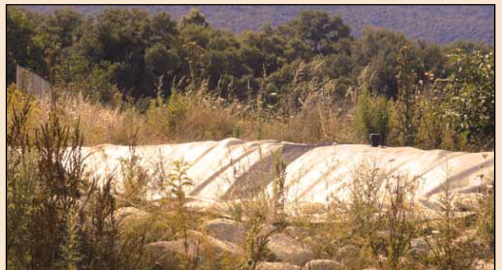
Centre d'enfouissement de Prunelli-di-Fiumorbu
